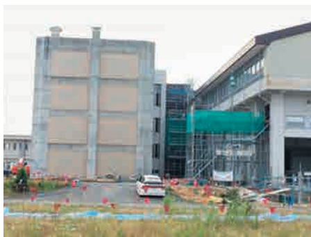
■ エレベータ工事（東側外観）
