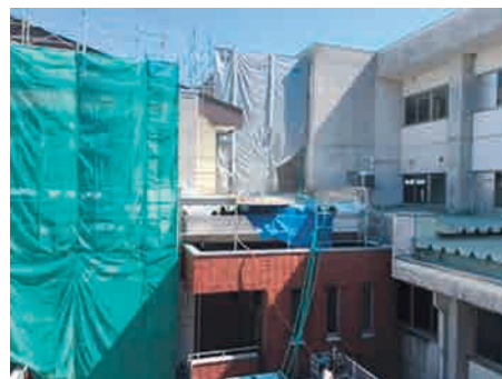
■ エレベータ工事（西側外観）
