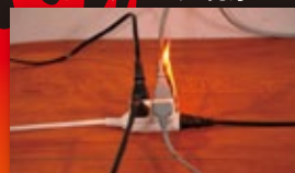
テーブルタップ・プラグ トラッキング現象
